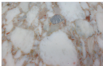
CONFORMACIÓN CON PIEDRAS GRISES (DETALLE)
