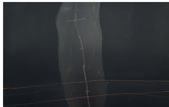
EXEMPLE DE COLORATION DE LA DALLE À COULÉE.
